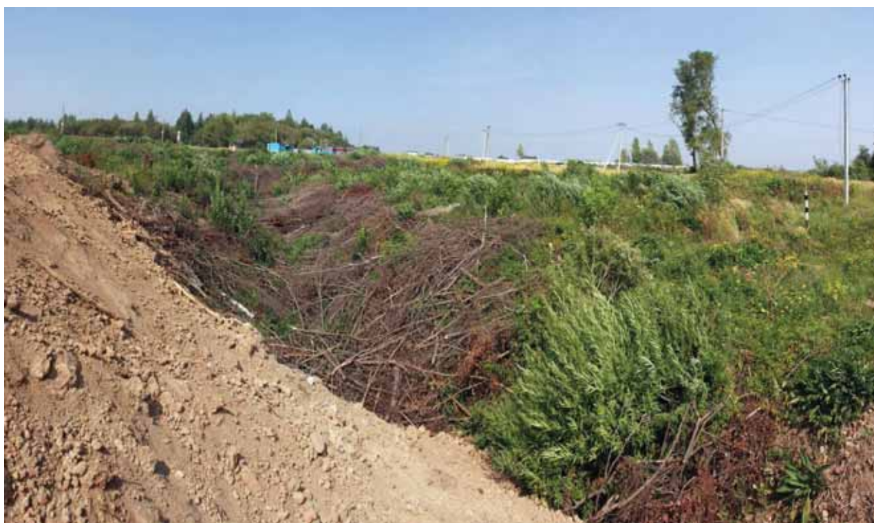
Срезанные деревья и кусты в оси подхода на расстоянии около 700 м от торца ВПП 26
